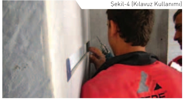
Şekil-4 (Kılavuz Kullanımı)
