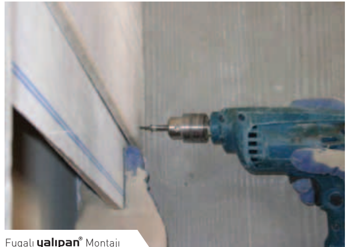
Fugalı yalıpan ® Montajı
