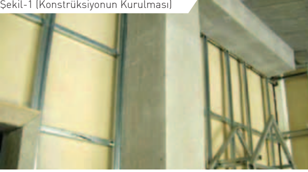
Şekil-1 (Konstrüksiyonun Kurulması)
