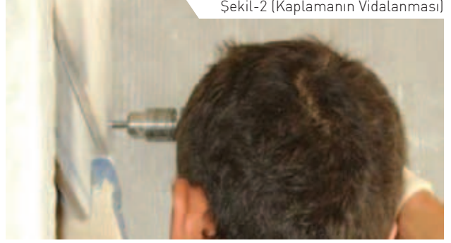
Şekil-2 (Kaplamanın Vidalanması)
