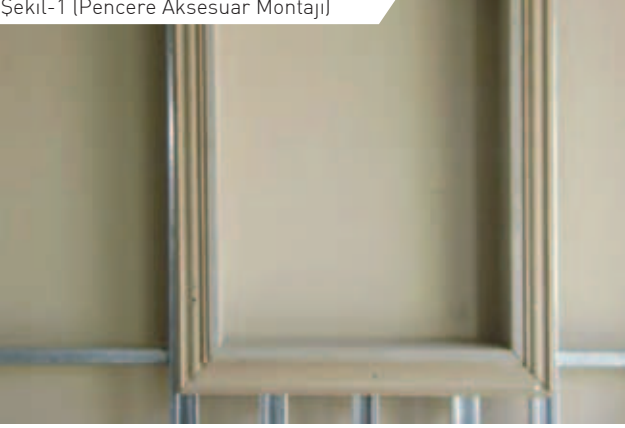
Şekil-1 (Pencere Aksesuar Montajı)
