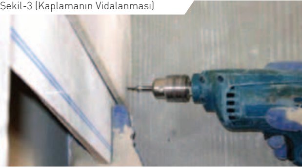
Şekil-3 (Kaplamanın Vidalanması)
