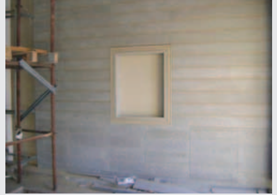
Montajı Bitmiş Yüzey
