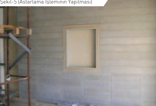
Şekil-5 (Astarlama İşleminin Yapılması)
