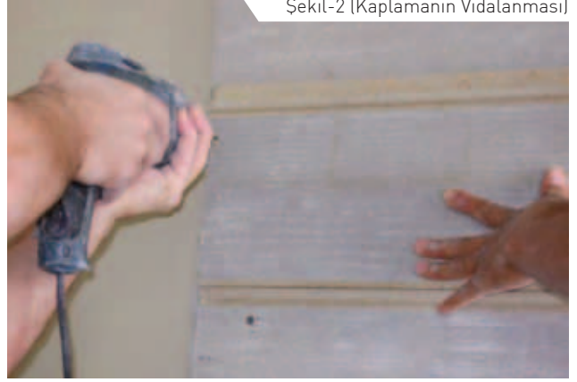
Şekil-2 (Kaplamanın Vidalanması)
