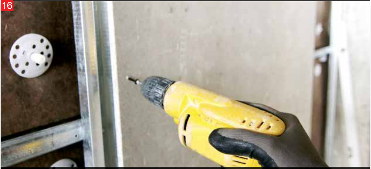
16 Kesim işlemleri tamamlanan levhalar M profiller üzerine paslanmaz vidalar kullanılarak montajlanır.
