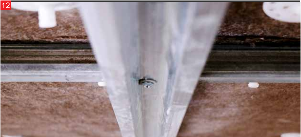
Kullanılacak M profiller galvanize, 25x80x3000 mm ebatlarında ve 0,50-0,55 mm kalınlıklarında olmalıdır. (M profil ebat ve kalınlığı yapılacak statik hesaba göre farklılık gösterebilir.)
