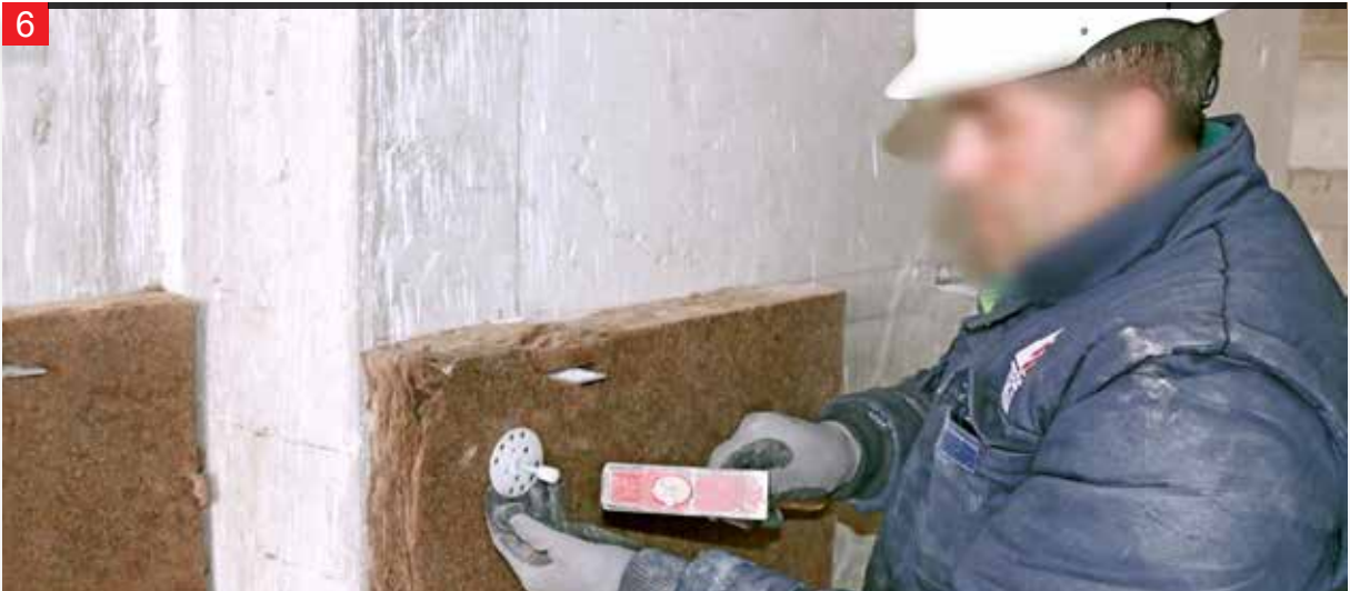
Uygulanan yalıtım malzemeleri paraşüt dübeller ile uygulama yüzeyine sabitlenir.
