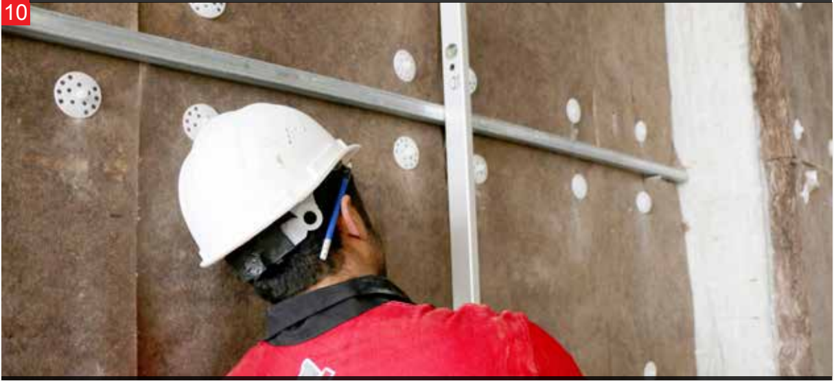
L profillerin terazisi montaj yüzeyi boyunca kontrol edilmelidir.
