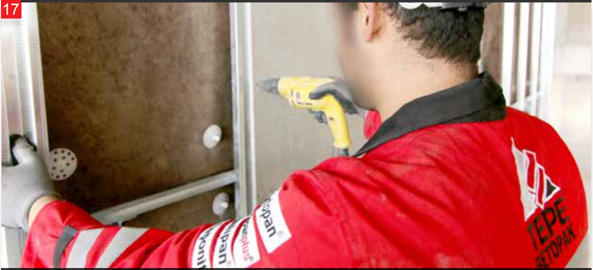
17 Levhalar, M profillerin kanatlarına paslanmaz vidalar ile vidalanmalı, vidalanma esnasında iki kanata sabitlenecek levhalar arası 0,5 mm boşluklar bırakılmalıdır.
