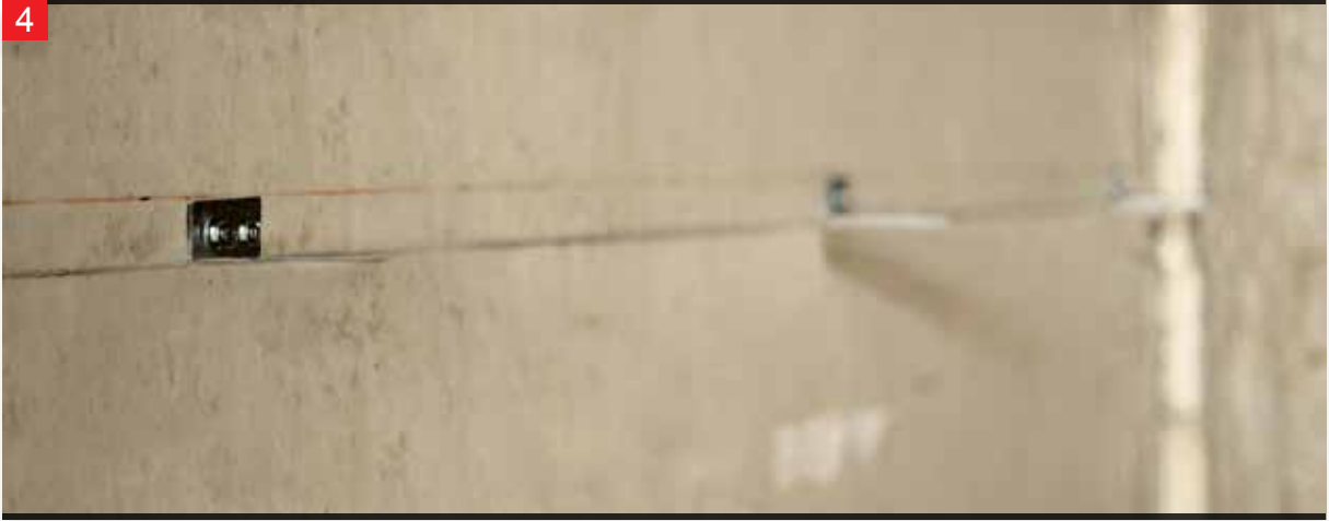
Dübel yerleri tespit edilen L konsollar duvar tipine uygun dübel kullanılarak sabitlenir.
