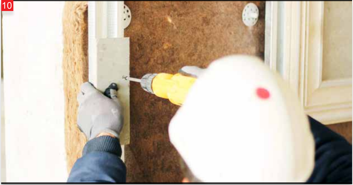
Sonraki levhanın geleceği alanın orta kısımlarına dengeleyici şeritler konumlandırılır.
