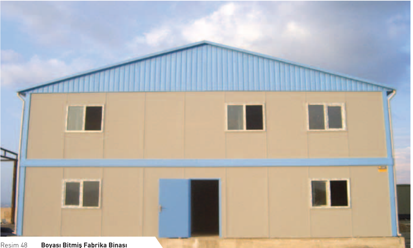
Resim 48 Boyası Bitmiş Fabrika Binası
