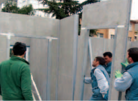
Resim 44 Prefabrik Bina İç Duvar Yapımı
