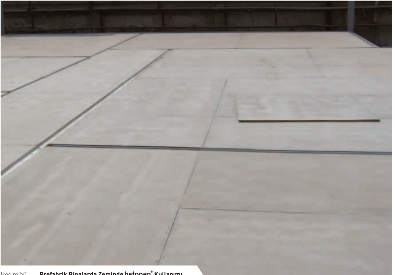
Resim 50 Prefabrik Binalarda Zeminde betopan ® Kullanımı
